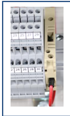
Figura 5. Portafusible cerrado.
