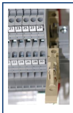
Figura 4. Portafusible abierto.
